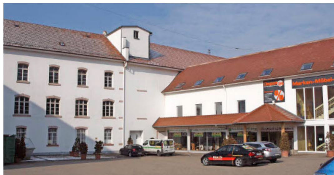
Vom Verbindungsbau zwischen der früheren Zigarrenfabrik Heppe und dem Barockbau mit dem Küchenstudio wird ein etwa zwei Schaufenster breiter Teil abgebrochen.
